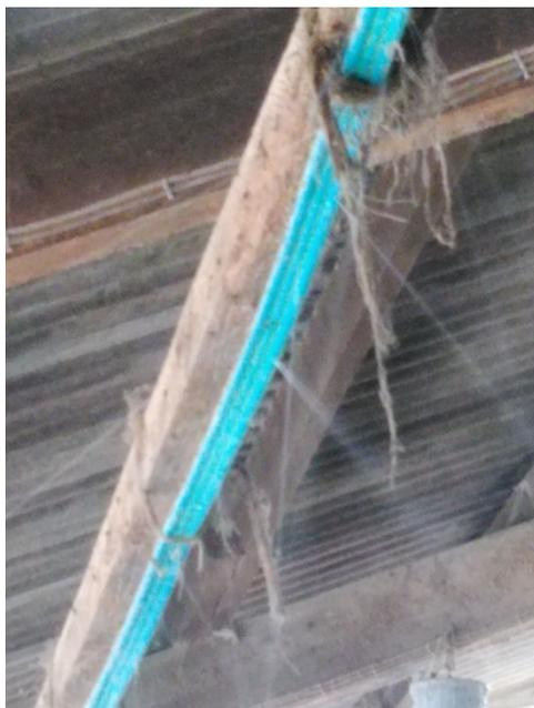
Ein gutes Beispiel ist auf dem Foto zu erkennen. Hier wurde ein handelsüblicher Beregnungsschlauch (Baumarktware) über dem Laufgang montiert.
